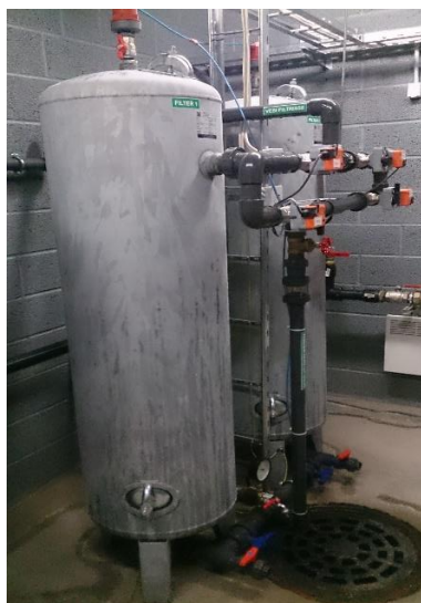
Foto 5.15 Viitna puurkaevpumpla veetöötlusseadmed ja õhukompressor
