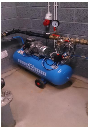
Foto 5.15 Viitna puurkaevpumpla veetöötlusseadmed ja õhukompressor
