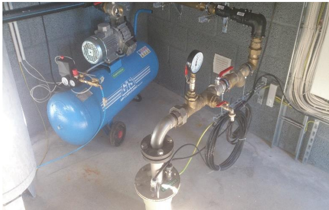
Foto 5.16 Vohnja küla puurkaevpumpla sisevaade (kompressor ja veetöötlus)
