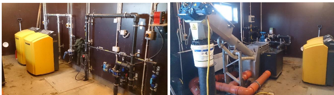
Foto 6.3 Hulja reoveepuhasti sisevaade – õhutuskamber ja järelsetiti
