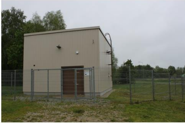
Foto 5.12 Viru puurkaevpumpla välis- ja sisevaade
