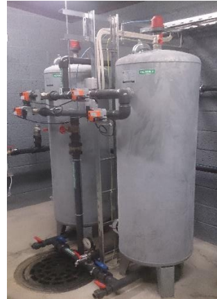
Foto 5.16 Vohnja küla puurkaevpumpla sisevaade (kompressor ja veetöötlus)
