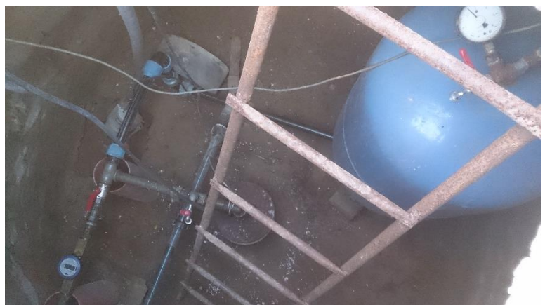
Foto 5.15 Kiku puurkaevpumpla välis- ja sisevaade (hüdrofoor, puurkaevu päis)
