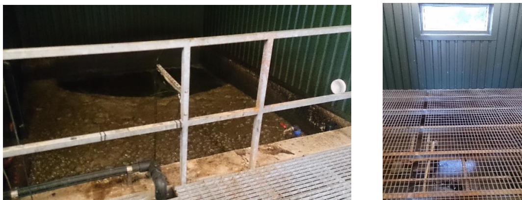
Foto 6.3 Hulja reoveepuhasti sisevaade – õhutuskamber ja järelsetiti
