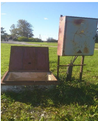
Foto 5.15 Kiku puurkaevpumpla välis- ja sisevaade (hüdrofoor, puurkaevu päis)
