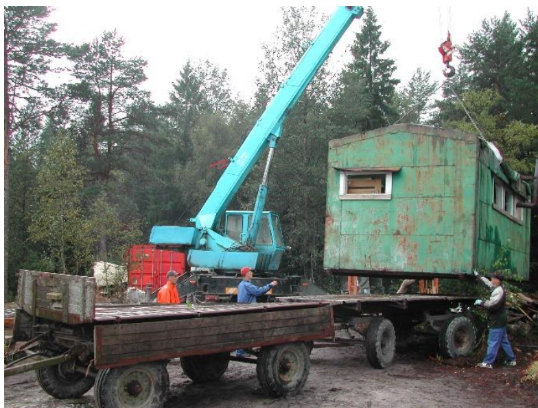
Foto 5. Soojaku paigaldamine
